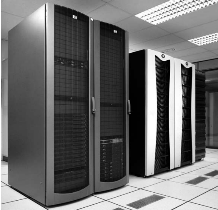
Gràfic 6. Maquinari del PADICAT a les instal·lacions del CESCA
